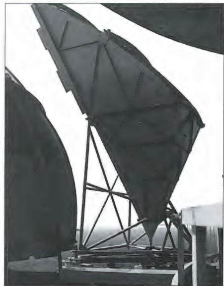
De hoornantenne wordt gebruikt voor telecommunicatie in de 4 GHz-band. Droge lucht wordt via kleine plastic slangetjes verbonden met de golfgeleiders (onderaan in de punt) binnengevoerd.
